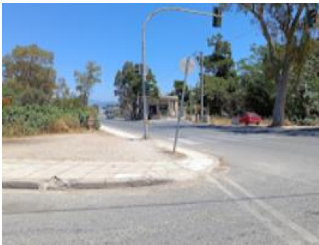
Εικόνα 87. Ράμπα ΑμεΑ στην οδό Υπαπαντής (Πηγή: Επιτόπια λήψη)
