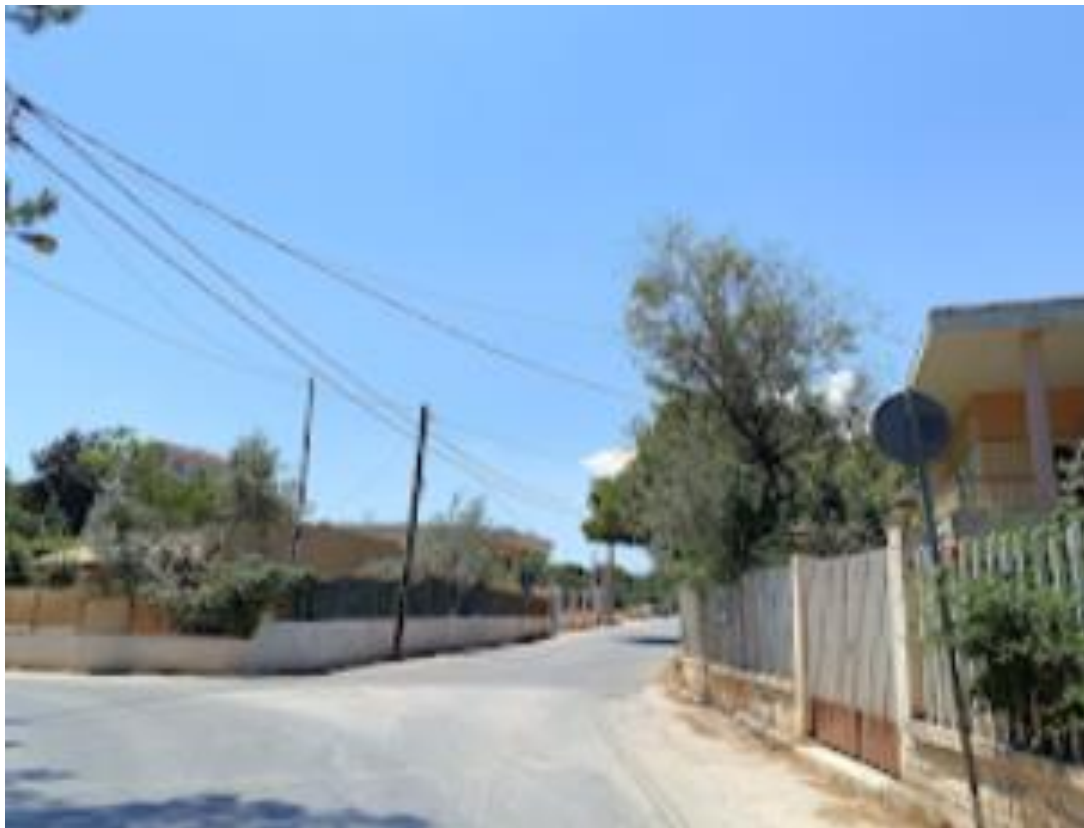
Εικόνα 86. Στιγμιότυπο διαδρομής στην οδό Ανθέων με απουσία πεζοδρομίων και επικίνδυνο σημείο (Πηγή: Επιτόπια λήψη)
