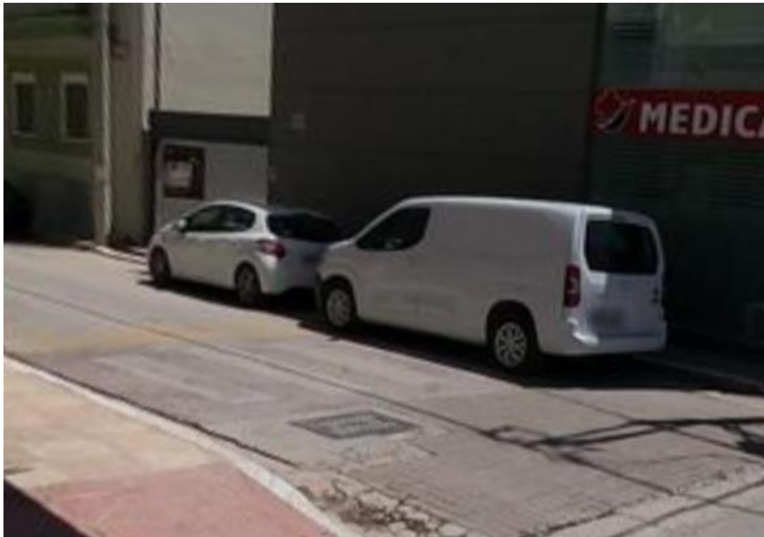
Εικόνα 82. Διάβαση πεζών, ανεπαρκές πεζοδρόμιο και ράμπα στην οδό Αύρας (Πηγή: Επιτόπια λήψη)
