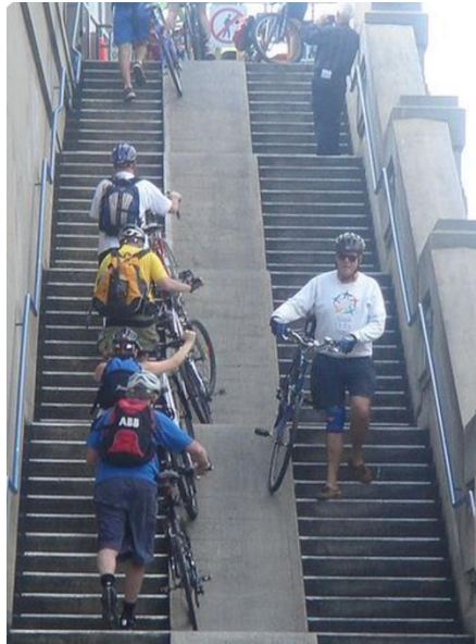
Εικόνα 30. Ράμπα για τη μετακίνηση ποδηλάτων σε διαφορετικά επίπεδα.
