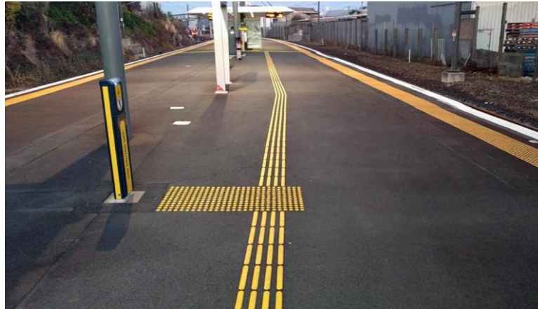
Εικόνα 11. Λωρίδα όδευσης τυφλών στο σταθμό τρένων Mount Eden, Ν.Ζηλανδία.
