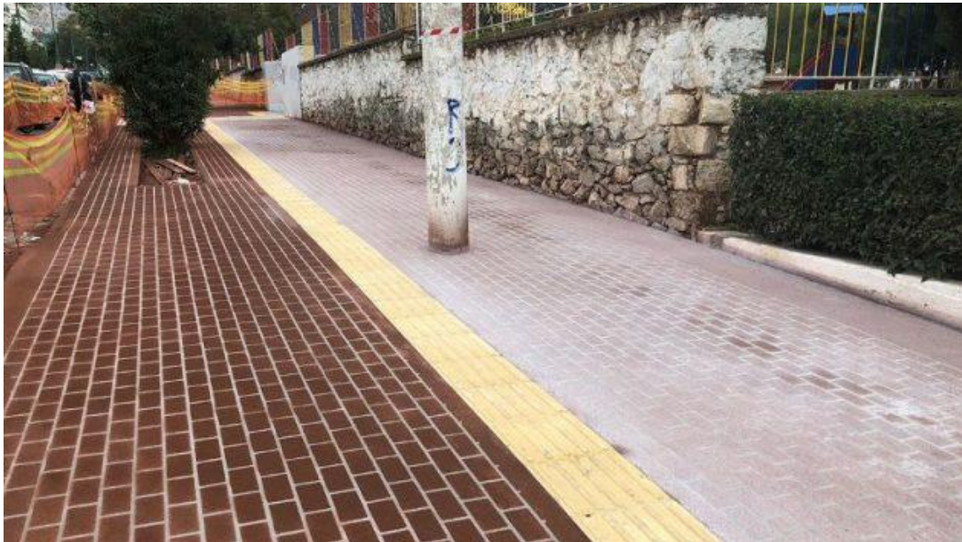
Εικόνα 32. Σταθερό, συνεχές και επιμελές αρμολόγημα (πηγή: https://www.michanikos-online.gr/ )
