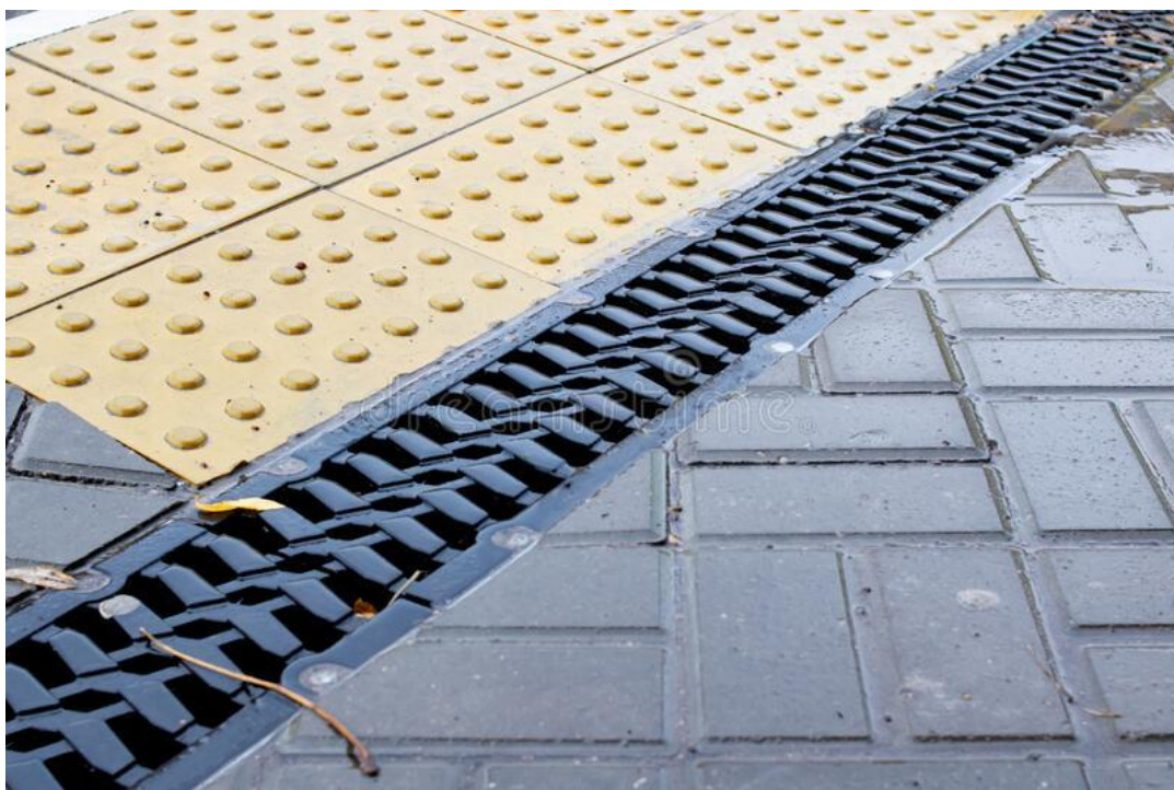
Εικόνα 33. Τοποθέτηση σχαρών στο πεζοδρόμιο (πηγή: https://es.dreamstime.com/ )
