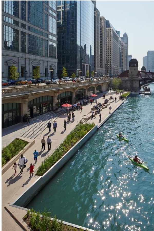
Εικόνα 3. Κεκλιμένο επίπεδο στο παραποτάμιο μέτωπο του Σικάγο, ΗΠΑ, που διευκολύνει την κίνηση ΑΜΕΑ.
