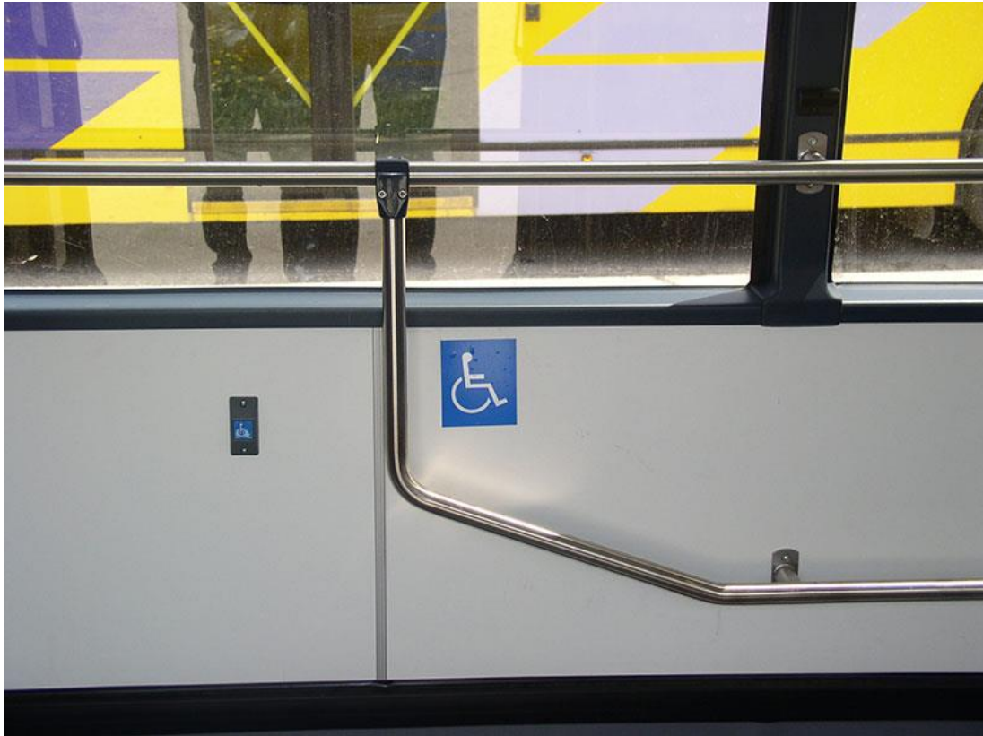
Εικόνα 55. Χώρος εξυπηρέτησης ΑμεΑ (πηγή: https://www.oasa.gr/ )
